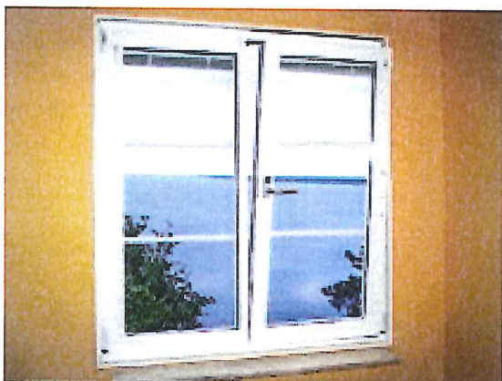
B – Kipp/Dreh-fönster i ventilationsläge.
